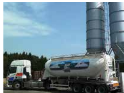
Zwischenpuffersilo – Füllung beim Lagerhaus mit dem Silo-Lkw
